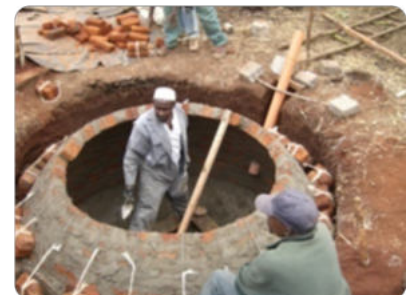
Bau von Biogasanlagen für Haushalte in Kenia
